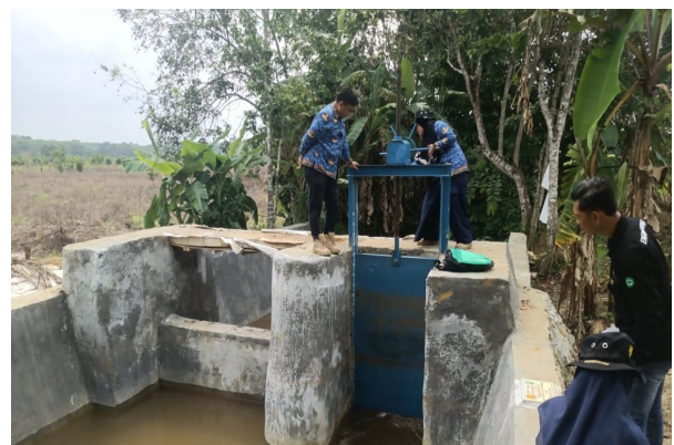
Gambar 2. Pemeriksaan Pintu Air
