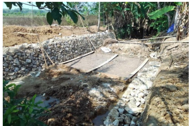
Gambar 4. Dokumentasi penulangan tubuh pintu air dan lantai cor beton
