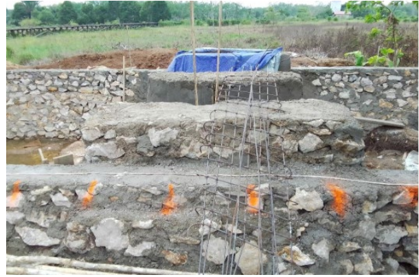
Gambar 3. Dokumentasi penulangan tubuh pintu air dan lantai cor beton
